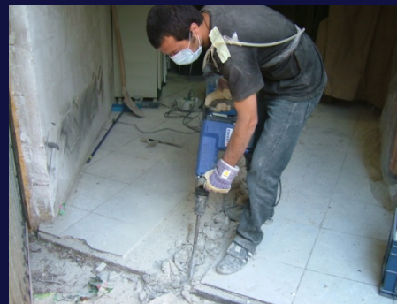
Demolizione pavimento
